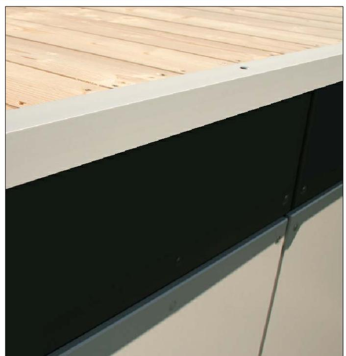
Befestigen Sie nun die Aluminiumschiene A100-220 (Winkelschiene) mit 7x B510 am Ende der überstehenden Dachschalung. Die Aluminiumschiene werden in der Standardlänge von 220cm geliefert und müssen bauseits angepasst werden. Sie sollten an den Längsstößen 2cm überlappen.
