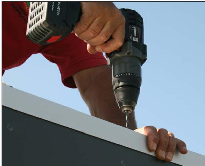
Verschrauben Sie die Aluminiumschienen ( A100-220) nach dem Vorbohren mit 6x C104-0030 an der Dachkante mit der Rähm. Lassen Sie die Längsstöße der Aluminiumschienen 2cm überlappen
