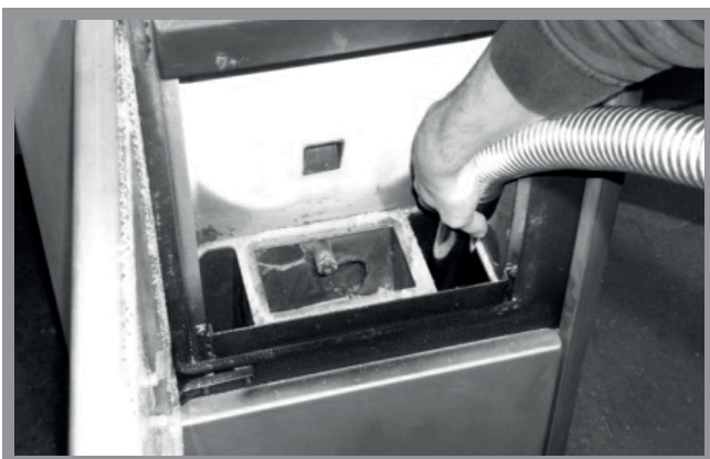
Abb. 12g: Reinigung untere Brennkammer
