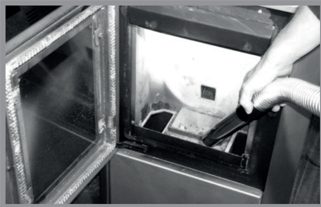
Abb. 12a: Reinigung des Brenntopfes
