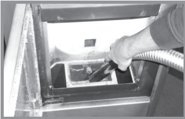
Abb. 12f: Reinigung Brennraumbehälter
