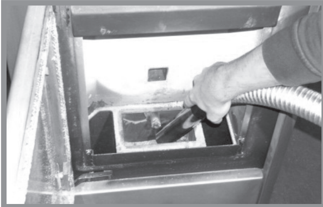
Abb. 12f: Reinigung Brennraumbehälter
