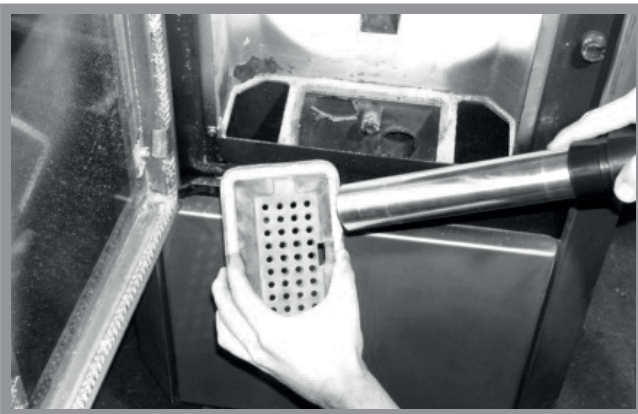
Abb. 12b: Reinigung der Luftöffnungen mit einem Staubsauger
