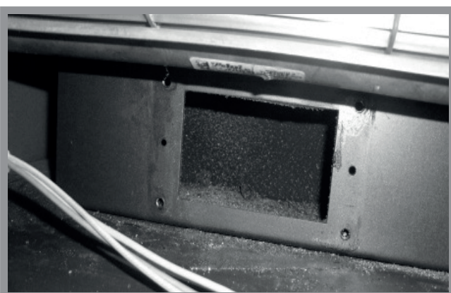
Abb. 13c: Aussaugen der Frontplatte
