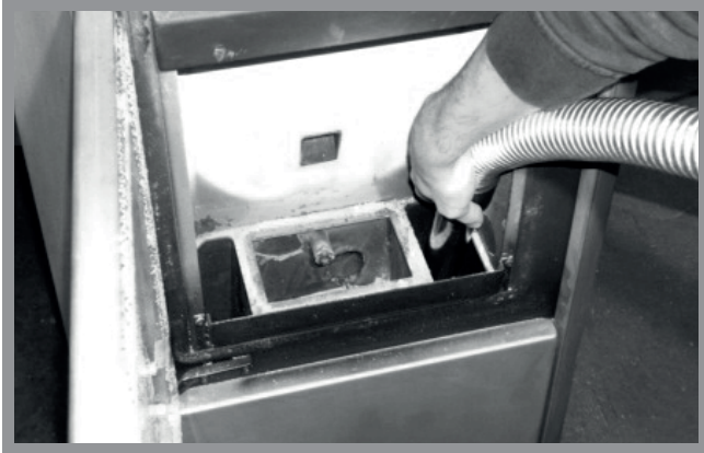
Abb. 12g: Reinigung untere Brennkammer
