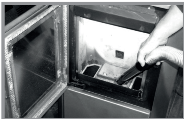
Abb. 12a: Reinigung des Brenntopfes
