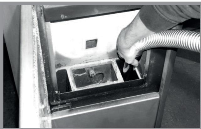
Abb. 12f: Reinigung untere Brennkammer
