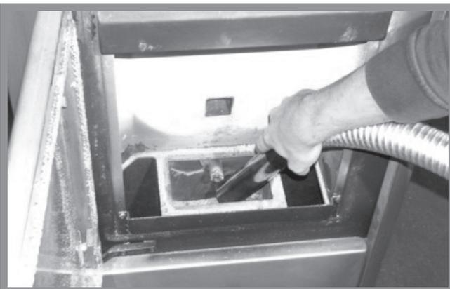
Abb. 12e: Reinigung Brennraumbehälter
