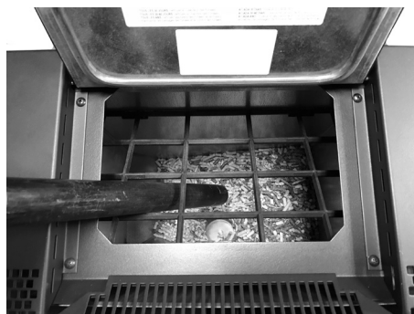
Fig. 12 - Reinigung Tank und Schnecke
