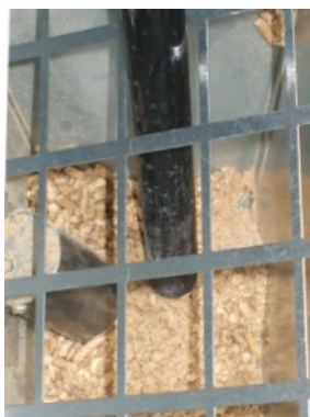
Fig. 59 - Reinigung Tank und Schnecke
