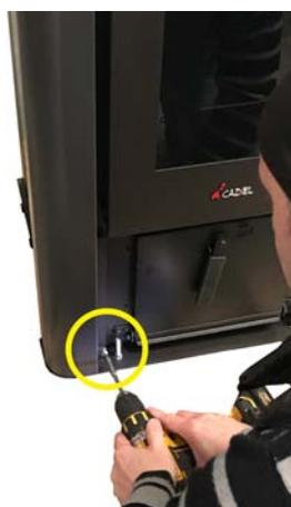
Fig. 24 - Befestigung des Rahmens
