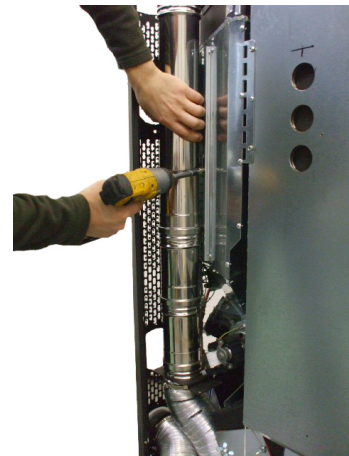
Fig. 30 - Befestigung der Rohre
