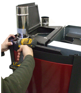
Fig. 47 - Entfernen der oberen gebogenen Profile
