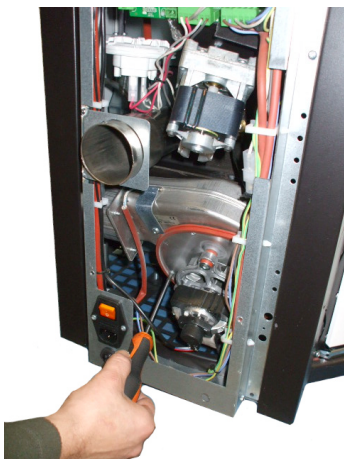
Fig. 59 - Reinigung Rauchgasansauggerät: Phase 1
