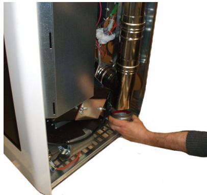
Fig. 58 - Reinigung des Rauchgaskanals
