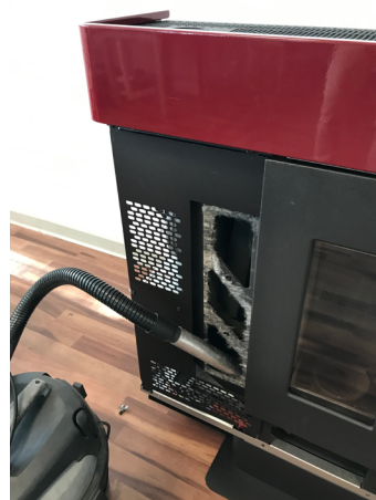
Fig. 77 - Reinigung Rauchgaskammer
