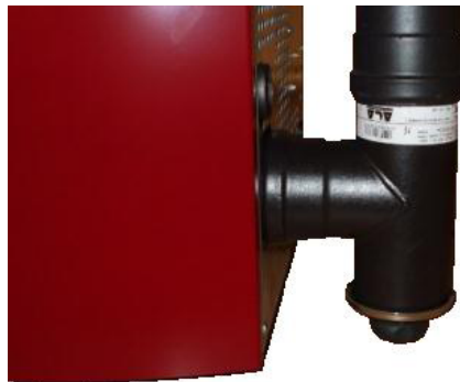
Fig. 97 - Reinigung des Rauchgaskanals
