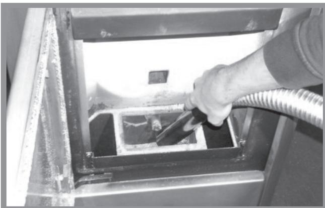
Abb. 12f: Reinigung Brennraumbehälter
