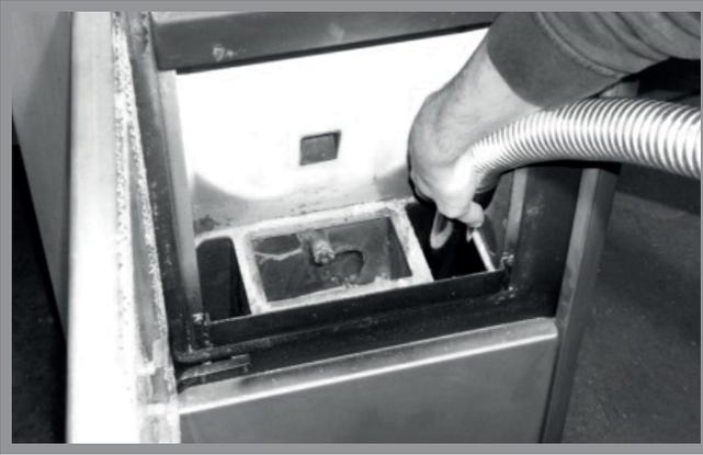
Abb. 12g: Reinigung untere Brennkammer
