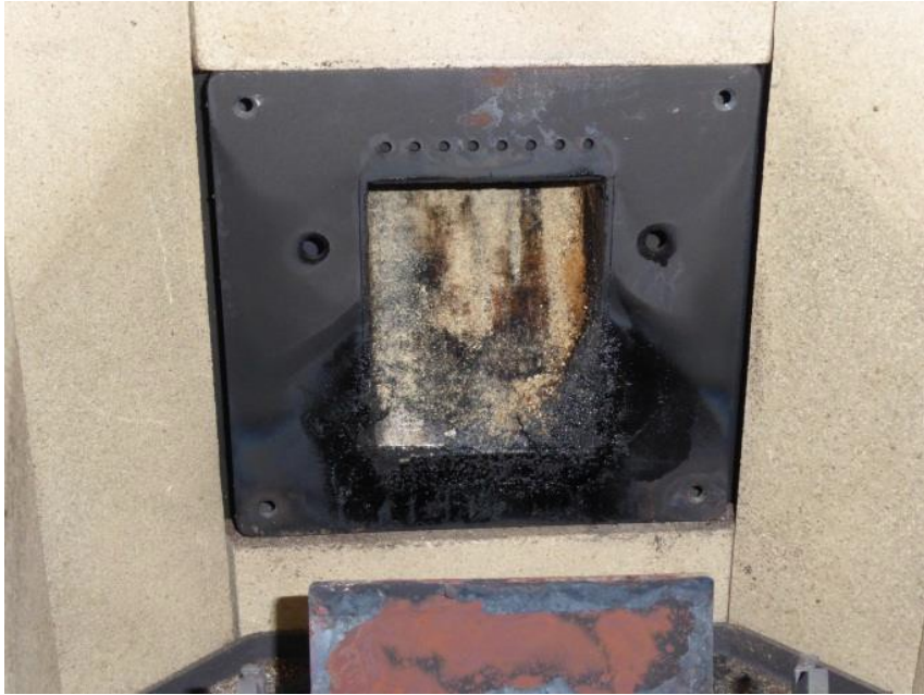
Ablagerungen am Boden des Pelletkanals nach dem Ausbau des Pelletbrenners.
