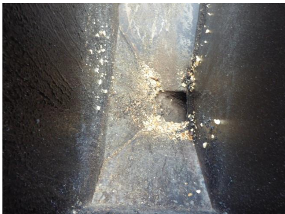
Ablagerungen durch feuchte Pellets und falsche Verwendung
