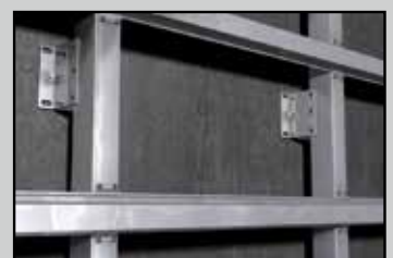
Fassadenunterkonstruktion
