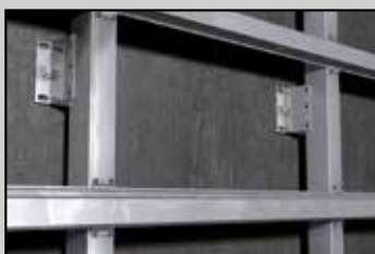
Fassadenunterkonstruktion
