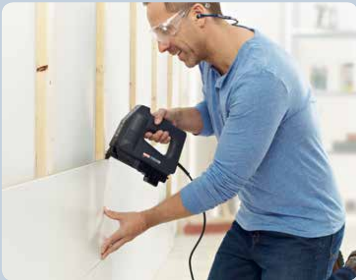
Direktes Befestigen von Profilhölzern.
