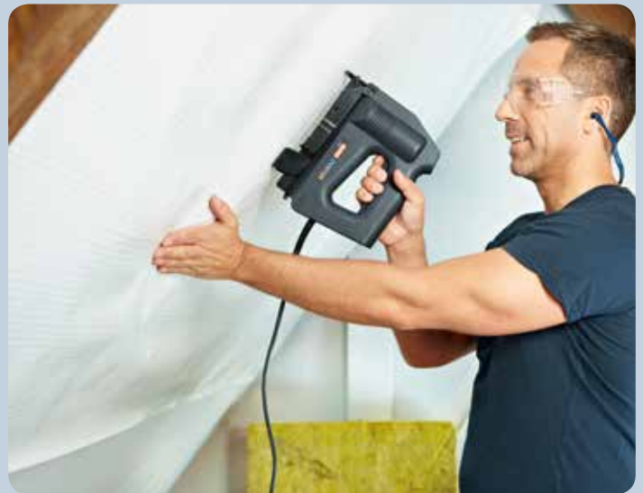
Folie beim Dachbodenausbau einfach befestigen.
