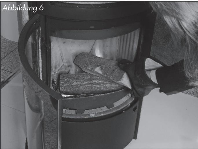
Die hier benannte Menge an Anzündholz und der Zeitpunkt der Reduzierung der Verbrennungsluft (Verbrennungsluftregler ganz bzw. teilweise schließen) können nur Anhaltswerte darstellen. Die optimale Menge bzw. die besten Reglereinstellungen hängen ganz erheblich von Art und Feuchtegehalt des Brennstoffs, der Witterung und den örtlichen Gegebenheiten (vor allem Schornsteinzug) ab.
