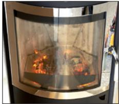
Sekundärluft: Komplett geöffnet ("MAX")
