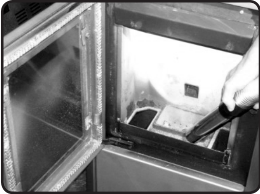
Abb. 14a: Reinigung des Brenntopfes
