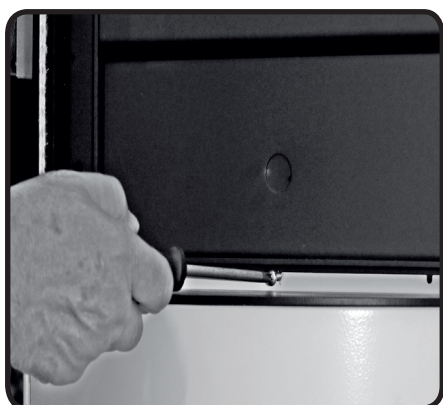
Abb. 15a: Öffnen der Frontplatte
