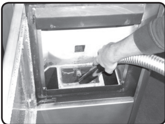
Abb. 14f: Reinigung Brennraumbehälter
