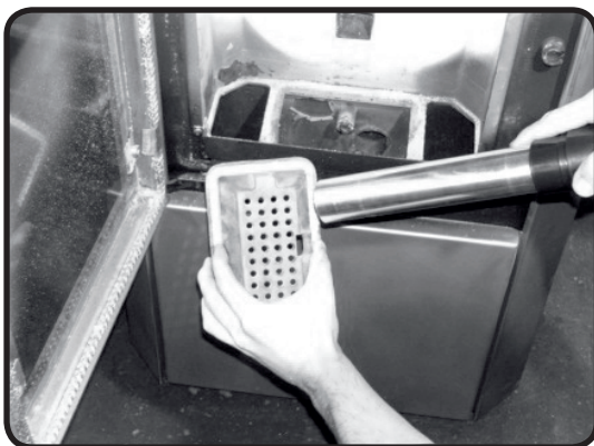
Abb. 14b: Reinigung der Luftöffnungen mit einem Staubsauger
