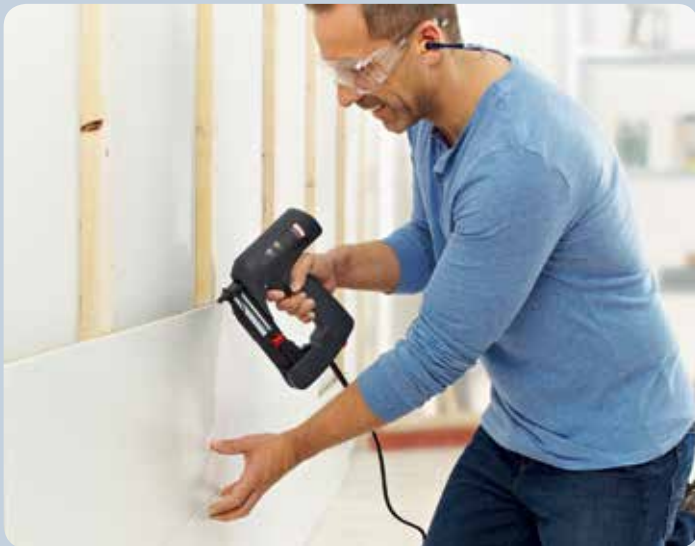
Direktes Befestigen von Profilhölzern.
