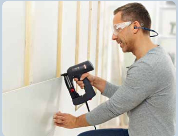
Profilhölzer mit Profilholzkrallen befestigen.
