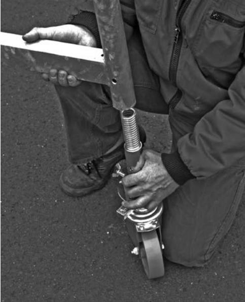
Dann werden die Fahrrollen, wie gezeigt, in die Fahrtraversen eingeschoben und mittels Flügelschraube an diesen befestigt.
