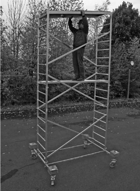
Hängen Sie dann die Belagbühne mit den dafür vorgesehenen Öffnungen in die obersten Sprossen der Vertikalrahmen ein. Ziehen Sie nun die schon vormontierten Sicherungssets fest an.
