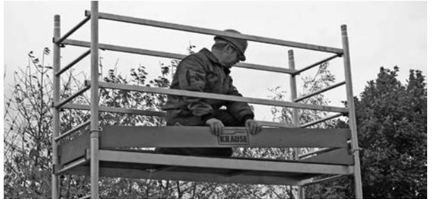
Die Abbildung zeigt das fertig montierte Gerüst mit einer Arbeitshöhe von 6,30 m.
