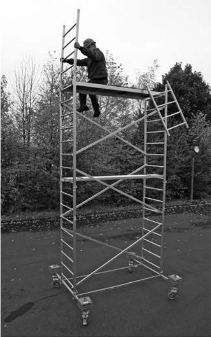
Steigen Sie vorsichtig nach oben, es ist noch kein Seitenschutz vorhanden. Bauen Sie die oberen, 1 m Vertikalrahmen ein und sichern Sie die Verbindungen mit den Fallsteckern.
